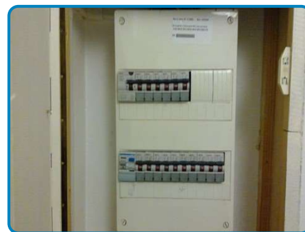
TRP n°1 sur Install. n°1 (dans Appartement 3ème étage Extérieur)
